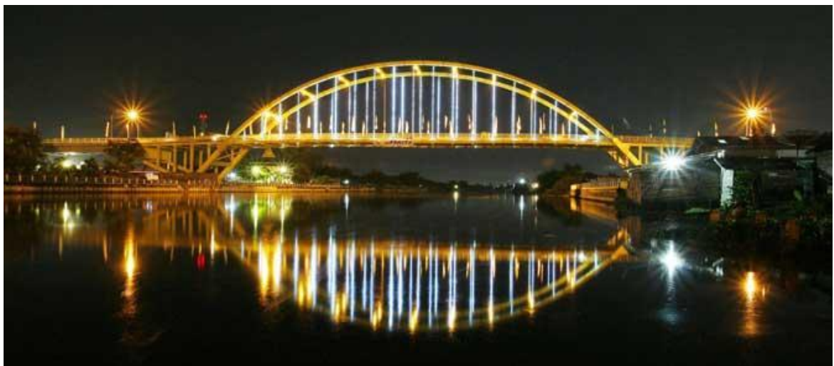
Jembatan Siak III
